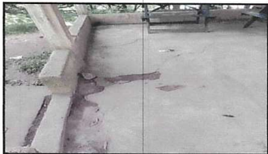
Foto1: Reemplazo de piso de salon y comedor
