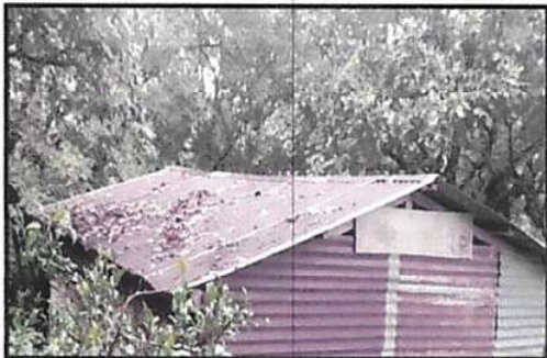
Foto 3: Reemplazo de techo y estructura metalica a los sanitarios.
