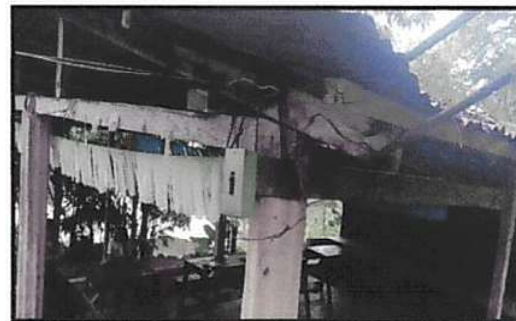
Foto 6: Reemplazo de cableado de electricidad
