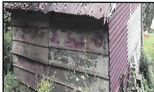
Foto 2: Mejoramientos de sanitarios con paredes de lámina trokelada y costaneras.
