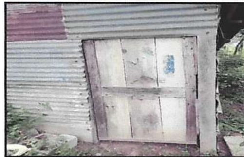
Foto 4: Reemplazo de puertas de metal a los sanitarios.
