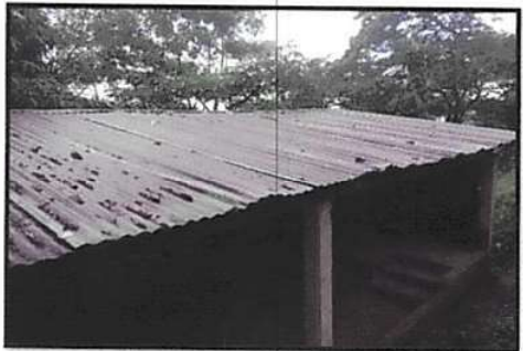
Foto 7: Reemplazo de techo de lamina de salón y comedor.
